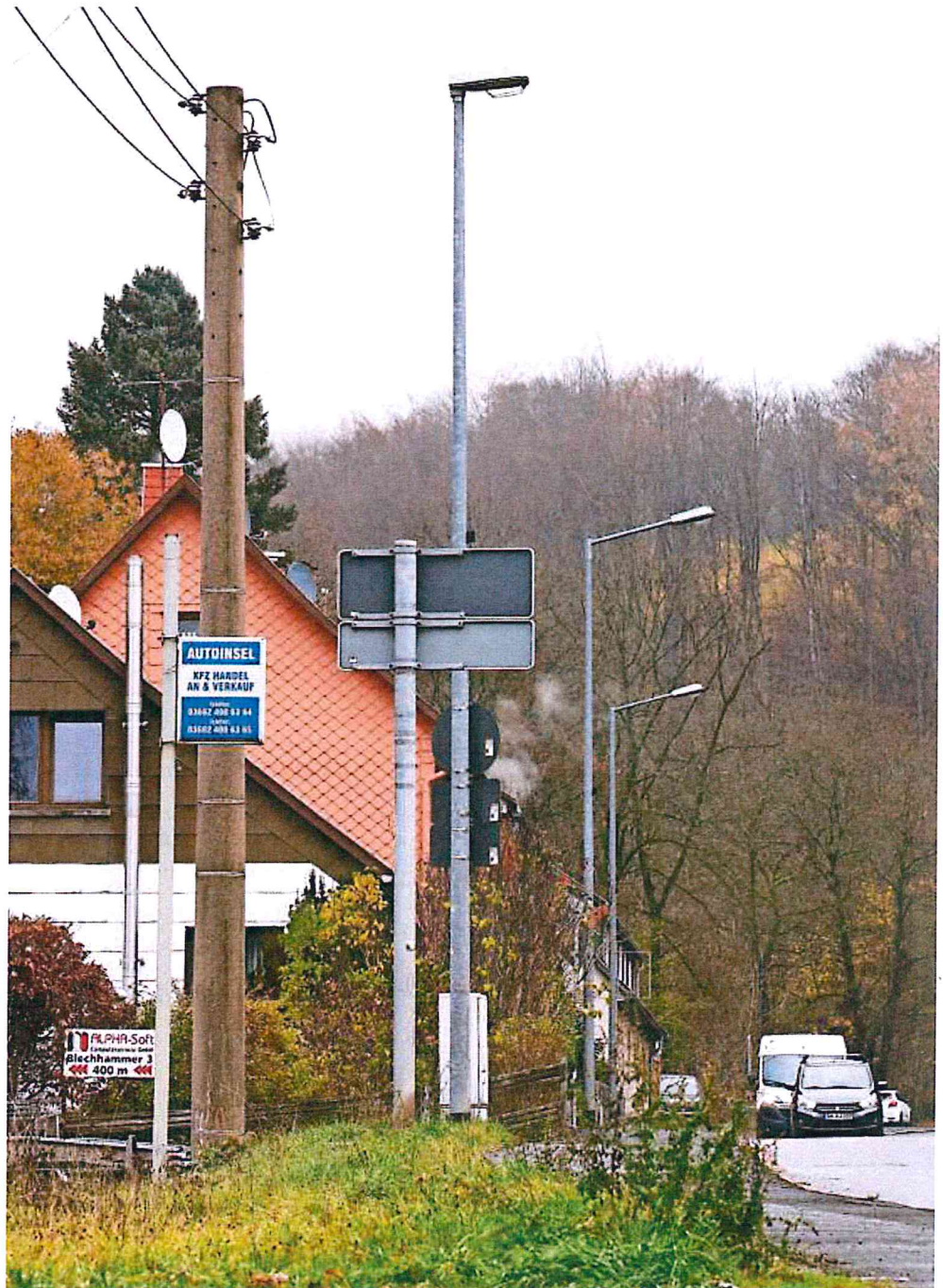
Lampen mit Ausleger und ohne, aus Beton und Stahl ziehen sich der Heinrich-Ehrhardt-Straße entlang. Nun soll aufgeräumt werden mit dem Chaos und die Leuchten in einheitliche Form gebracht werden. Foto: Michael Baurath
