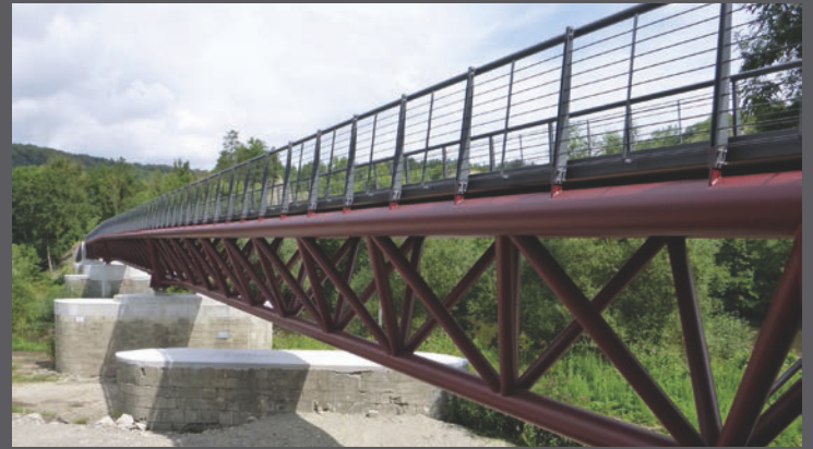
Werratalradweg Abschnitt Creuzburg - Überbauerneuerung an der Werrabrücke
