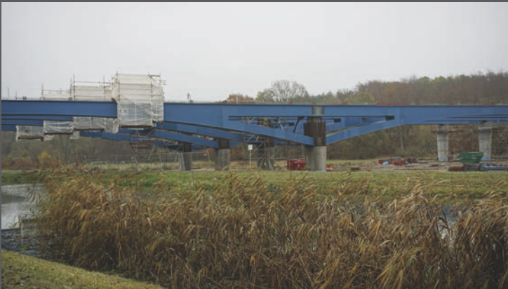
BAB A14 Neubau Eldetalbrücke - Montageüberwachung
