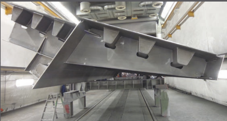
Ersatzneubau Rheinbrücke Schierstein - Fertigungsüberwachung
