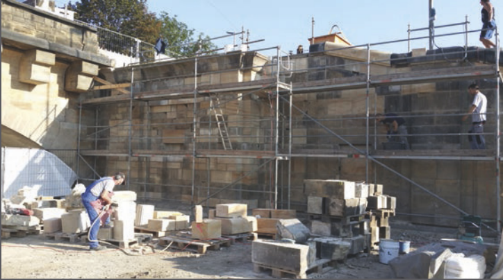
vorgez. denkmalgerechte Instandsetzung Nebenanlagen Augustusbrücke Dresden
