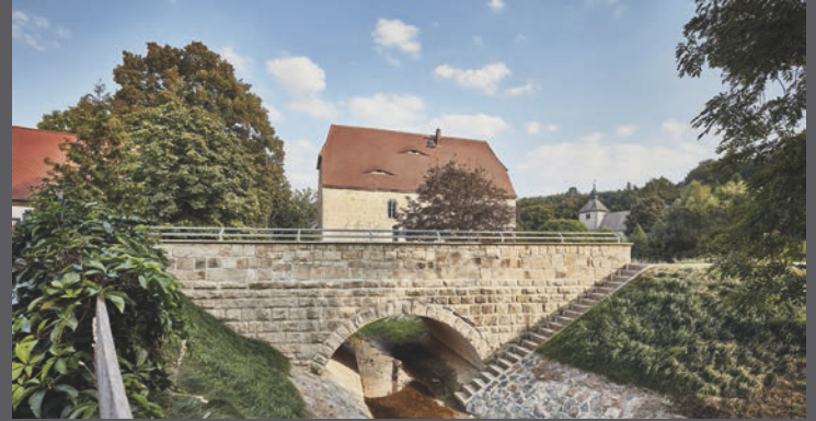
Brücke über den Hasselbach, Burgheßler
