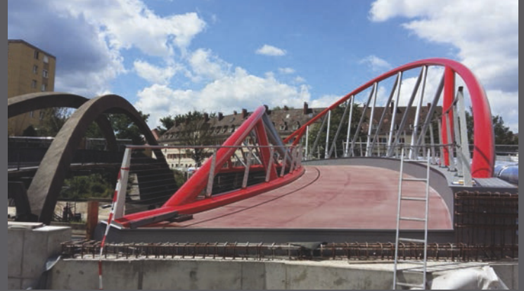
Ersatzneubau Heistersteg über den Frankenschnellweg, Nürnberg
