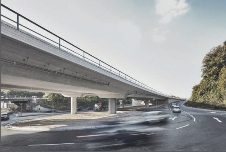
Straßenbrücke über den Amöneburger Kreisel, Wiesbaden
