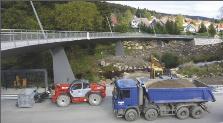
Fußwegbrücke Parkhaus am Winterbergtor, Schierke
