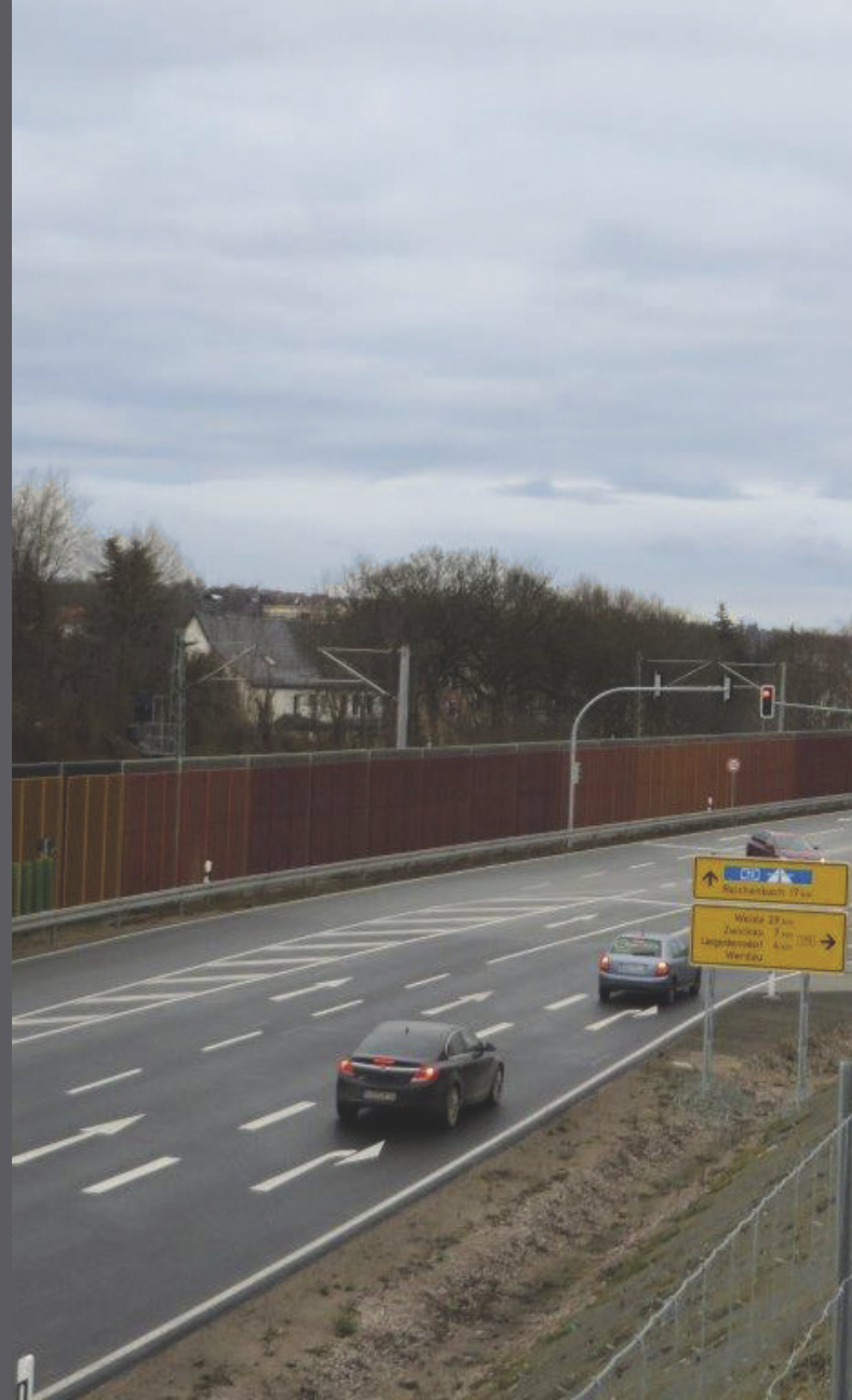
S 289 Verlegung nördlich Werdau
