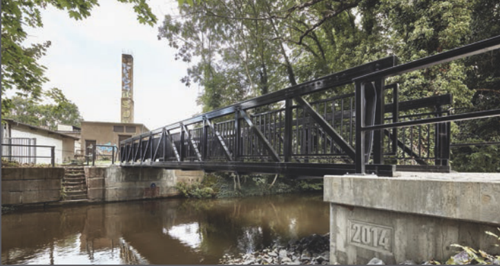
Brücke über den Elstermühlgraben, Pegau
