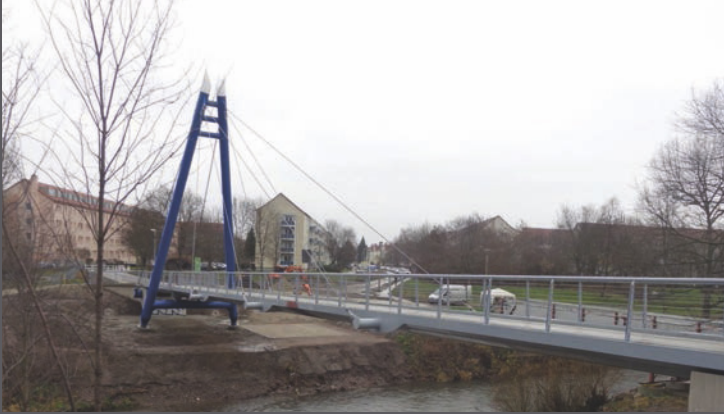
Ersatzneubau Gerabrücke „Pappelstieg“, Erfurt
