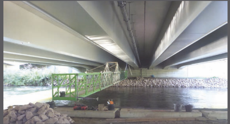
Kleine Elsterflutbrücke, Halle/S.
