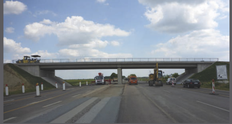
Brücke über die B 100 bei Landsberg
