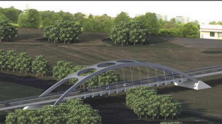
Brücke über die Saale in Hof
