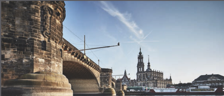
denkmalgerechte Instandsetzung der Augustusbrücke in Dresden
