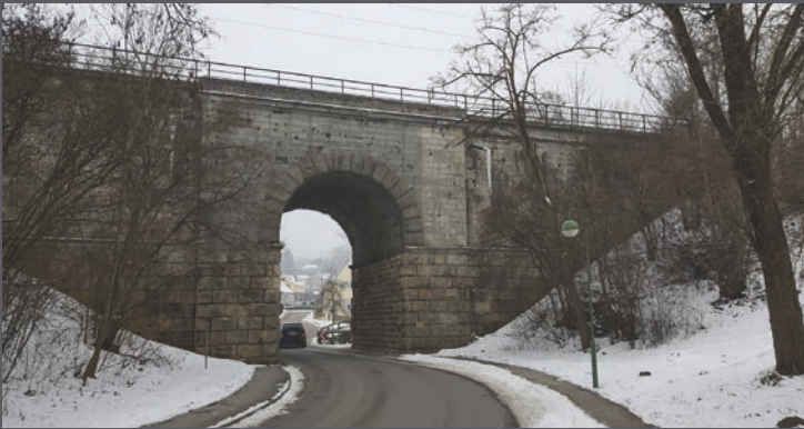
Instandsetzung denkmalgeschützter Eisenbahnbrücken der ehemaligen Ludwig-Süd-Nord-Bahn in Ebermergen
