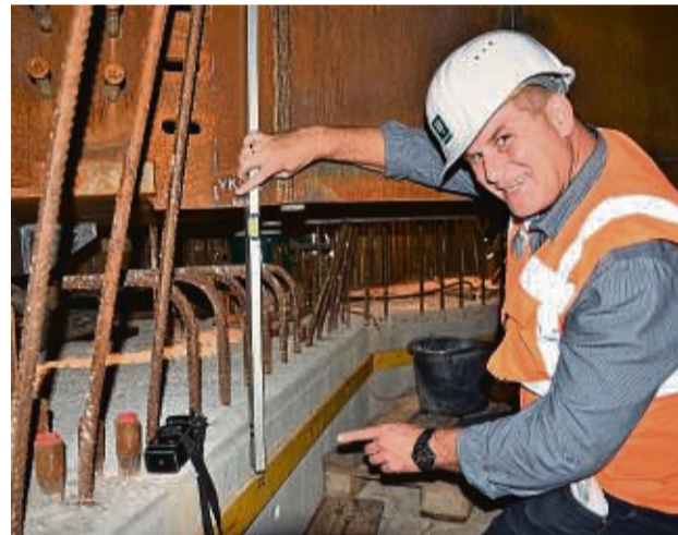
Der Träger liegt richtig: Oberbauleiter Knut Frank hat überprüft, ob Trägerachse und Bauwerksachse miteinander harmonieren. Mehr Fotos auf hna.de/bebra.
