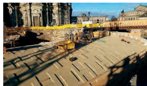
Bogen I - Schalung mit Matrise in historischer Kassettenstruktur
